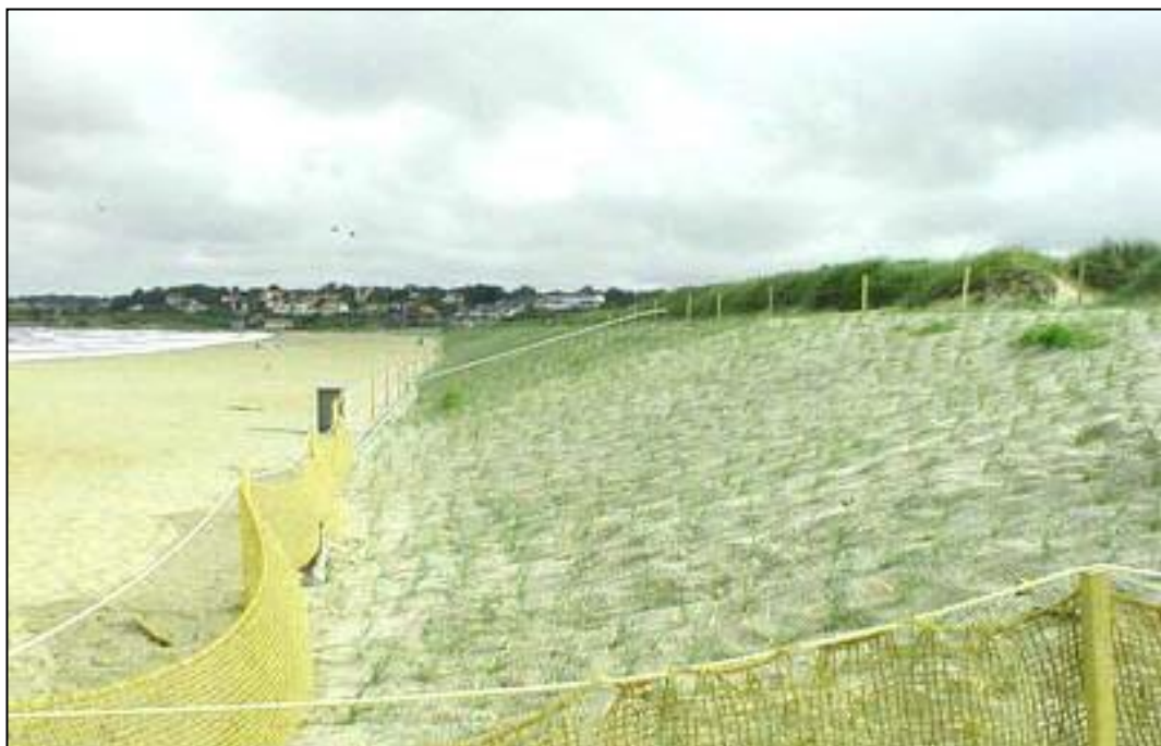
Figur 6-4 Konstgjorda sanddyner med gabionkärna och planterad strandrågför att binda sanden, Ängelholm.
