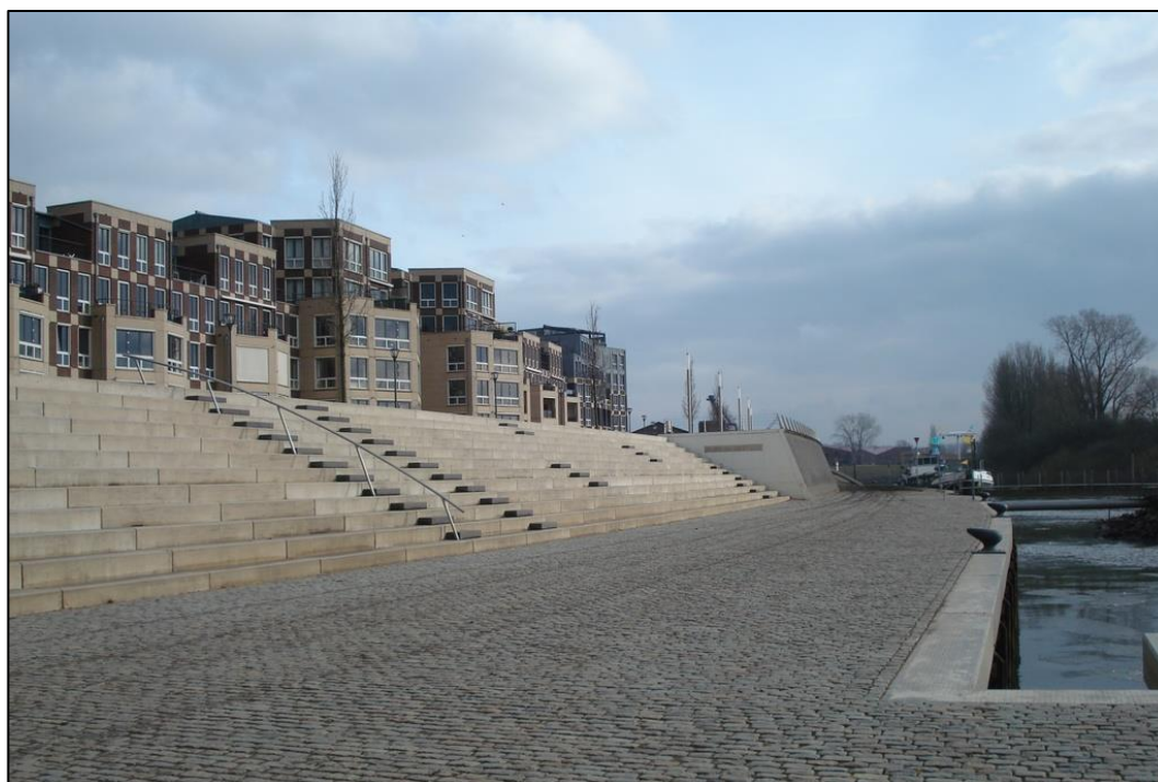
Figur 6-1 Upphöjd bebyggelse som skydd mot översvämningar i Doesburg, Nederländerna. Bakom de byggnader man ser på fotografiet är lägre bebyggelse belägen.
