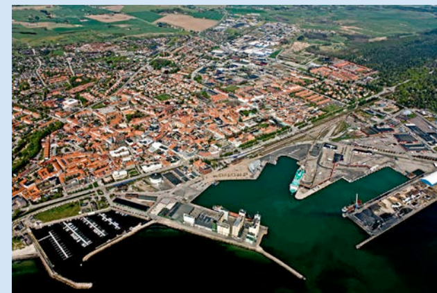
Hamnen kommer att byggas ut och tillgängligheten till den behövs säkerställas.
