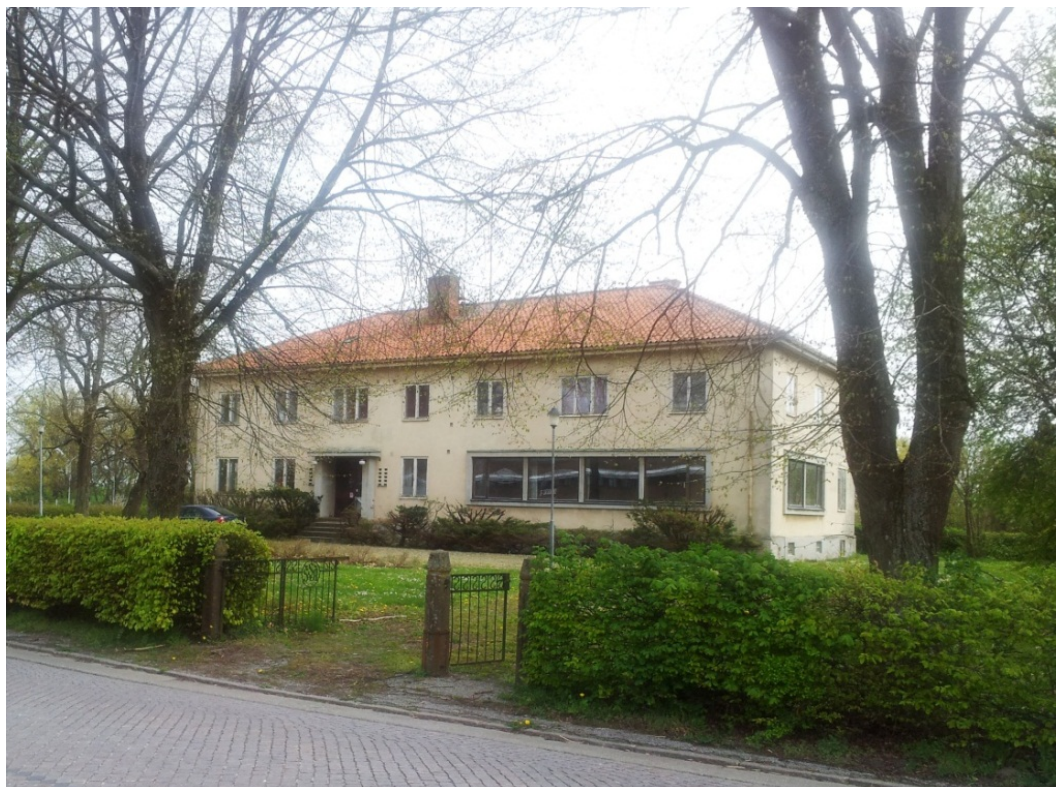
Kamrerhuset sett från nordväst. Foto: Ystads kommun.
