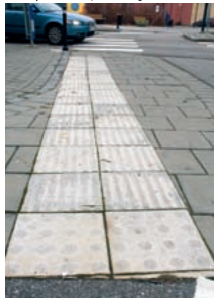
Taktila plattor i avvikande form och färg, leder synskadade på rätt väg.
