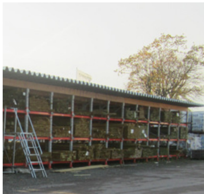
Exempel på förvaring av träskyddsbehandlat virke under tak
