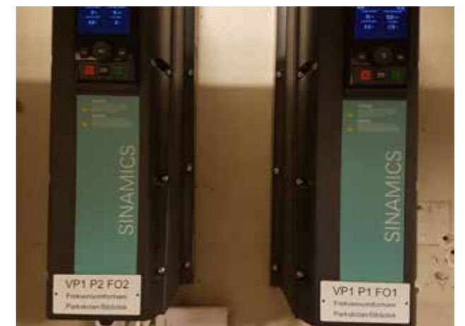
Tryckstyrning installerade på huvudpumparna för värmen i värmecentralen.
