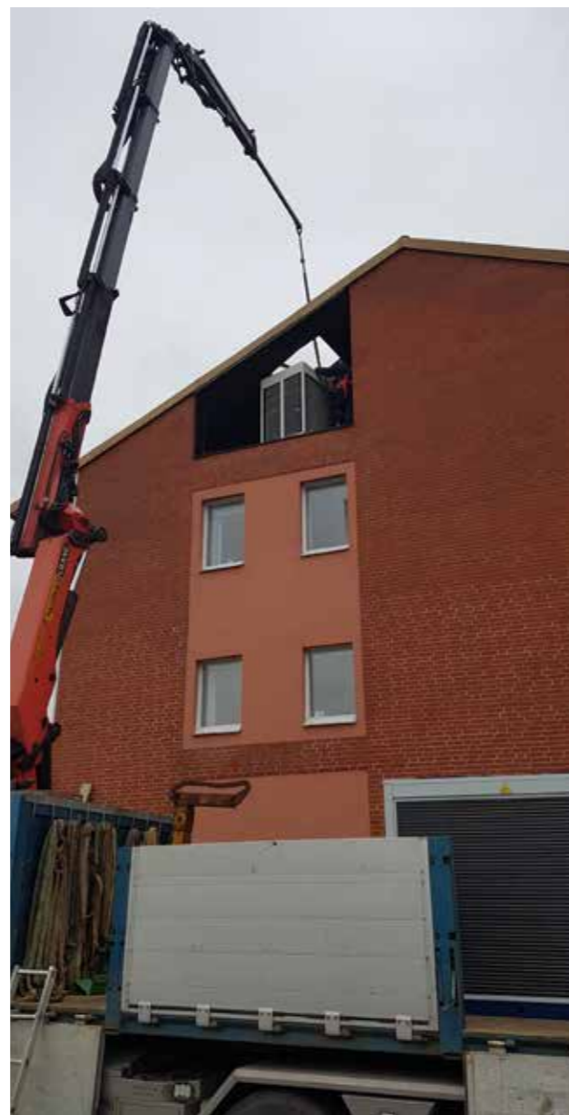
Socialkontoret på Blekegatan har fått ett nytt kylaggregat som under vår och höst kan hjälpa till med uppvärmningen.
