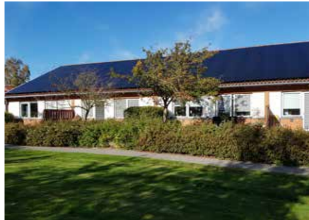
Solbackens äldreboende är en av två solcellsanläggningar som installerades under 2017.
