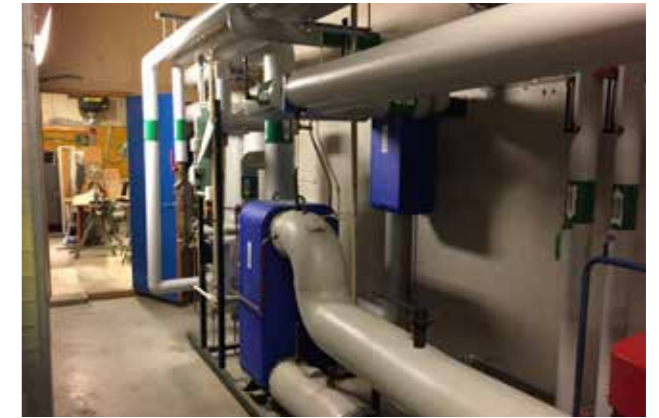
Värmeförlusterna i kulverten har sänkts genom att varmvattenberedaren flyttades till värmecentralen.
