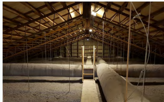
Tilläggsisolering på Löderupsskolans sporthall.
