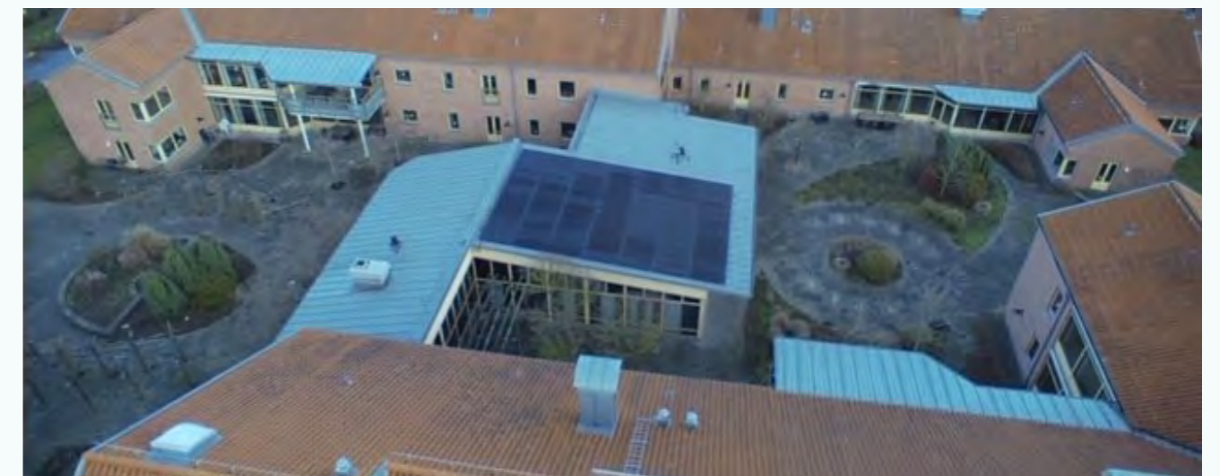
Nya energieffektiva ventilationsaggregat med inbyggd styr har installerats på Ljuskällan.
