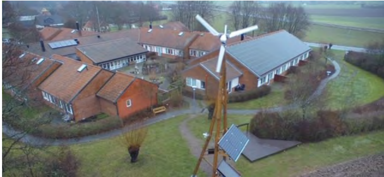
Solpaneler, vindkraftverk och solfångare på Solbackens särskilda boende.
