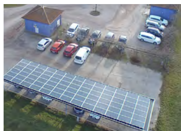
Solceller på Vigavägen installerades på carport.
