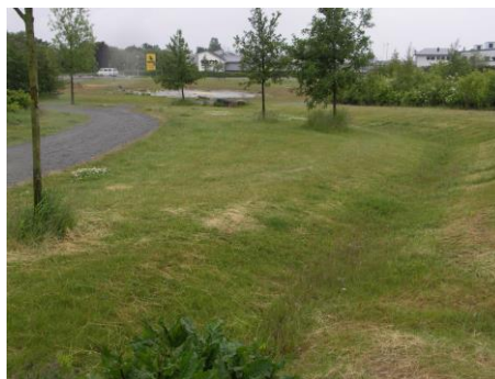
Uppsamlingsdike för dagvatten
