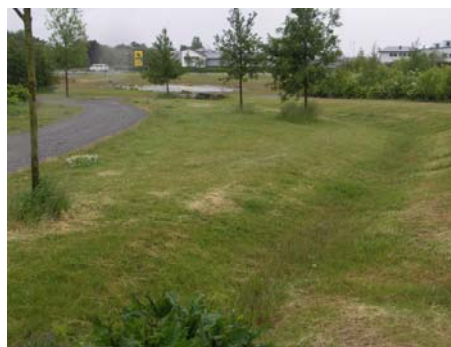
Uppsamlingsdike för dagvatten
