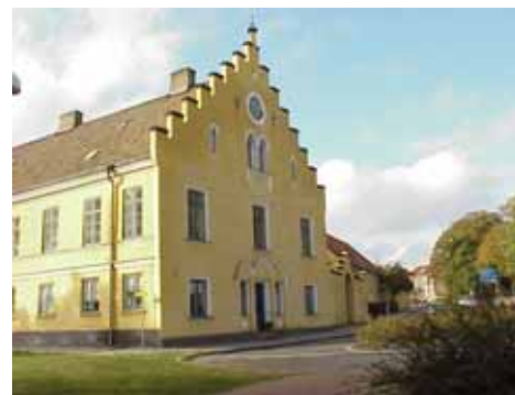
KLINTEHUS 1 A från SO
