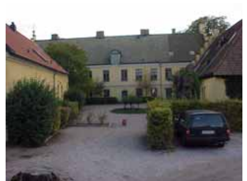
KLINTEHUS 1 från N
