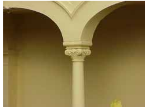
KLINTEHUS 1 A från V, LOGGIA DETALJ
