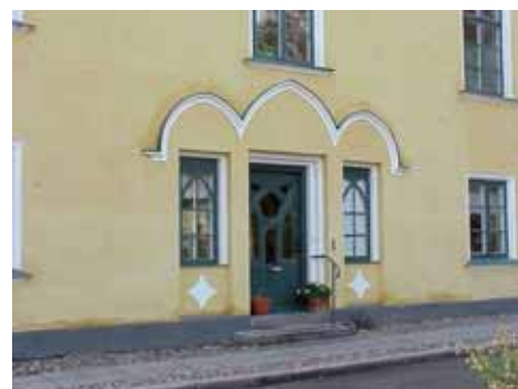
KLINTEHUS 1 A, ENTRÉ
