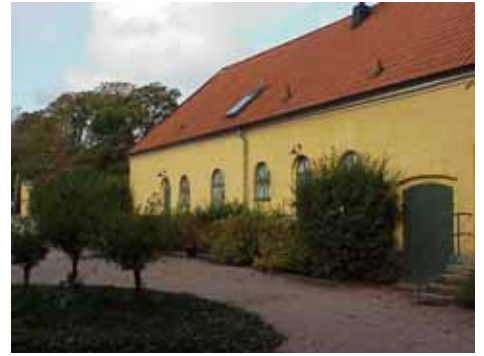
KLINTEHUS 1 B från S
