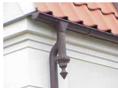
BLEKAN 8 A från SO STUPRÖRSHUVUD
