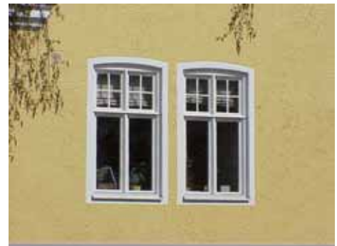
BOFINKEN 7 från V FÖNSTER
