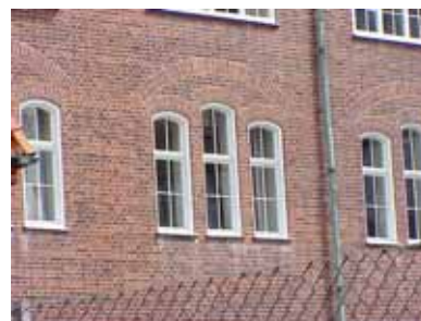
BRUZELIUS 2 B från V FÖNSTER
