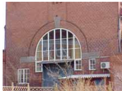
ELVERKET 11 från NV FÖNSTER
