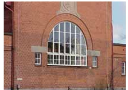
ELVERKET 11 från SV FÖNSTER
