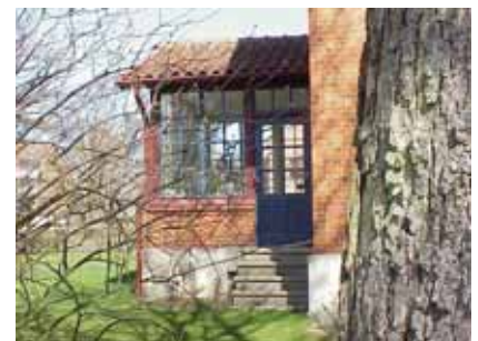
ELVERKET 10 A från S VERANDA
