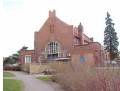
ELVERKET 11 från NV
