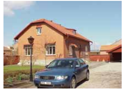
ELVERKET 8 A från SO
