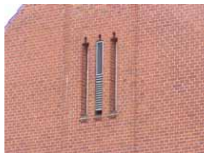
ELVERKET 11 från NV MURÖPPNINGAR
