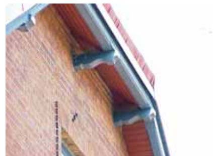
ELVERKET 10 A från S TAKFOT
