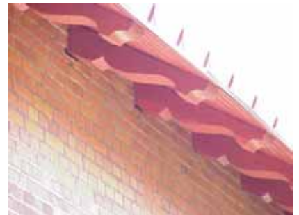
ELVERKET 8 A från N TAKFOT
