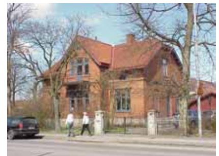
ELVERKET 10 A från SO
