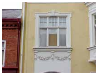
GÖKEN 7 B från S FÖNSTER
