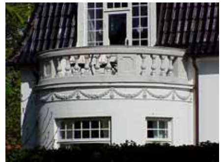
LÄRKAN 4 A från S BALKONG
