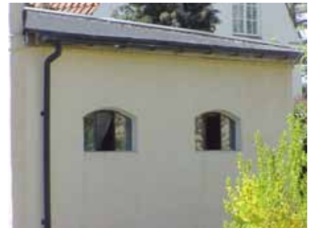
LÄRKAN 1 B från NO FÖNSTER
