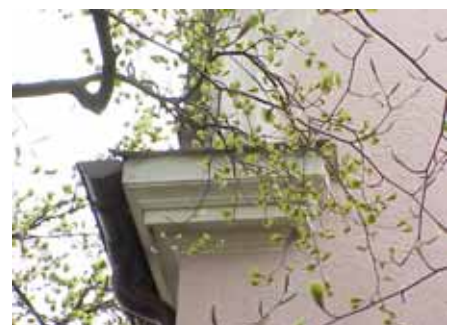
NÄKTERGALEN 1 A från N GESIMS
