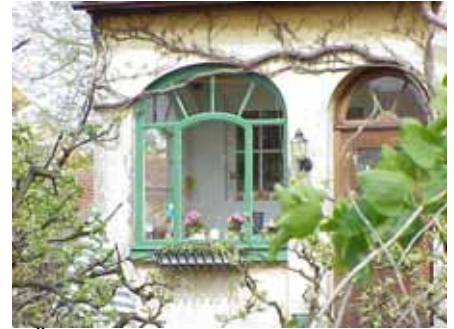
NÄKTERGALEN 4 A från SV FÖNSTER
