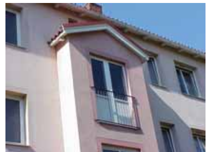
ÖSTMAN 2 A från SO TRAPPHUSTORN
