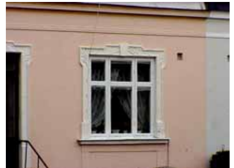
SOLDALEN 18 A från V FÖNSTER
