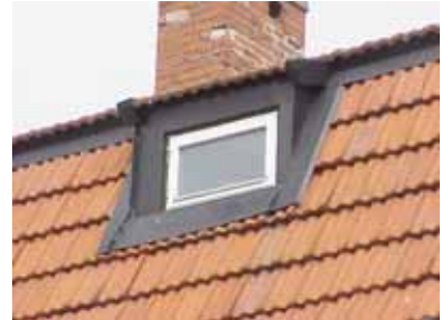
WEDBERG 13 A från SV MANSARDFÖNSTER
