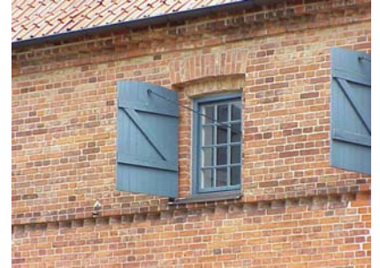
RISSELMAGASINET från SV FÖNSTER
