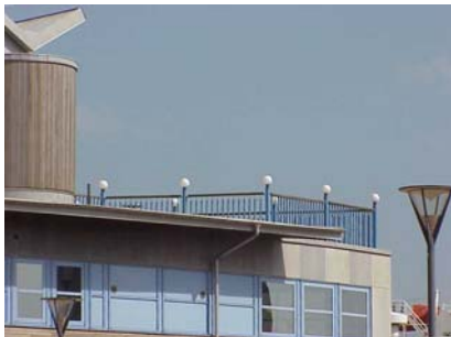
TERMINALEN från NV TERRASS
