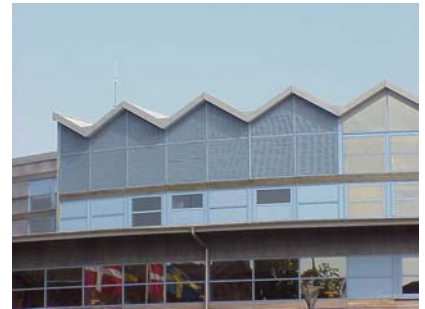
TERMINALEN från NV TAKKANT
