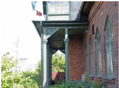
VARMBADHUSET från V LOGGIA
