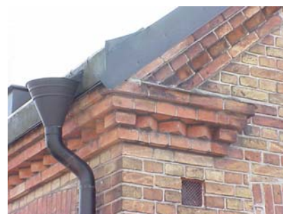
BERGMAN S 15 B från NV TAKFOT
