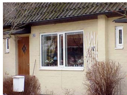
FRIDHEM 2 från NV, FÖNSTER
