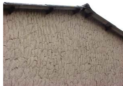
HAAK S. 1 B från NV PUTSVÄGG
