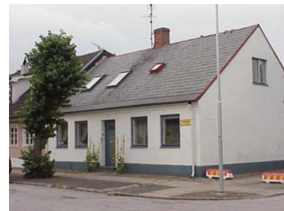
JÖNSSON S. 13 A från SO
