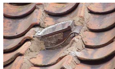
UPPENDICK S. 1 B från V TAK- FÖNSTERFÄSTE
