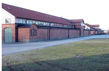
BYGGNAD 27 från SO
