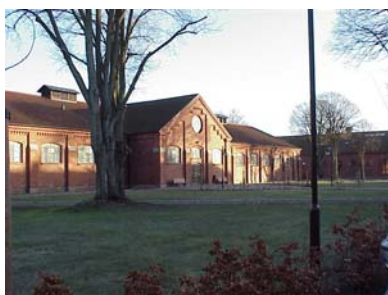
BYGGNAD 8 från NV
