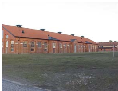
BYGGNAD 26 från SV
