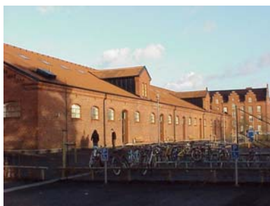
BYGGNAD 12 från SV
