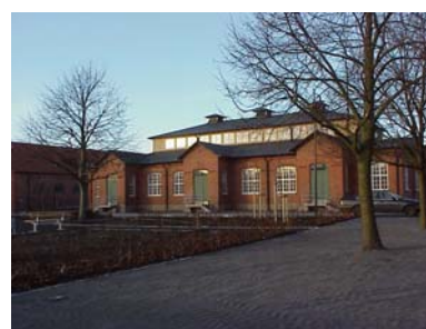
BYGGNAD 44 från SO
