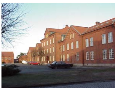
BYGGNAD 2, 25, 3 från SV
