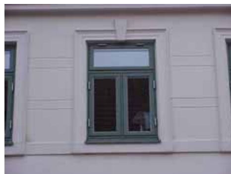
FREDRIK 17 A från S FÖNSTER
