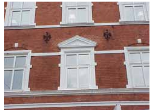
FREDRIK 2 A från S FÖNSTER
