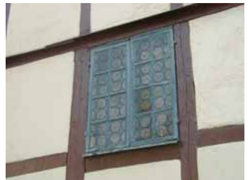
QVIST 10 B från NV FÖNSTER
