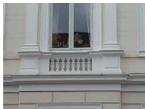
WILHELMINA 10 A från SO BALUSTRAD
