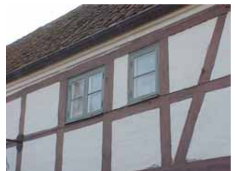
YNGVE 4 D från N FÖNSTER
