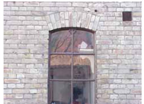
YNGVE 5 B från N FÖNSTER
