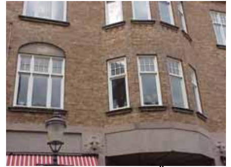
ADOLF 2, hus B från S FÖNSTER
