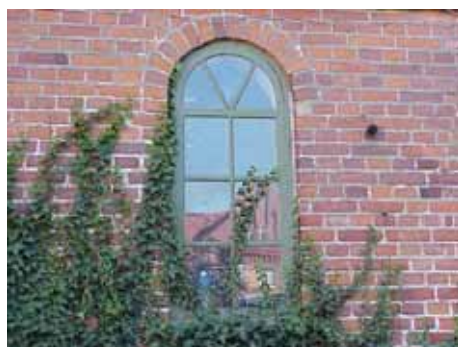
AGNES 19, hus B, fönster
