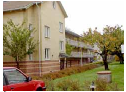
ÄNKEHUSET 2 D från NO
