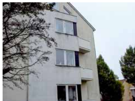
ÄNKEHUSET 1 från N
