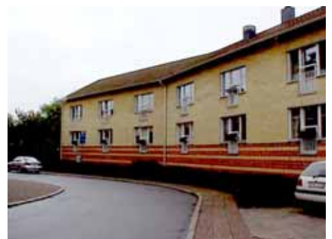
ÄNKEHUSET 2 E från N
