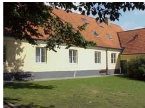
ÄNKEHUSET 2 A från SV
