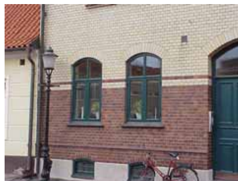
ERIK 25 A från S, FÖNSTER
