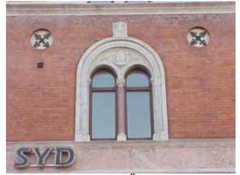
ESTER 4+5 från N FÖNSTER
