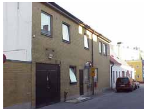
FRIGGA 5 B från NV
