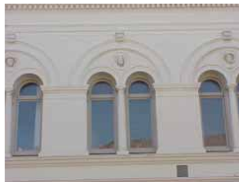
FRIGGA 4 A från O FÖNSTER
