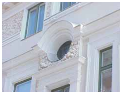
FRIGGA 7 från NV RUNT FÖNSTER
