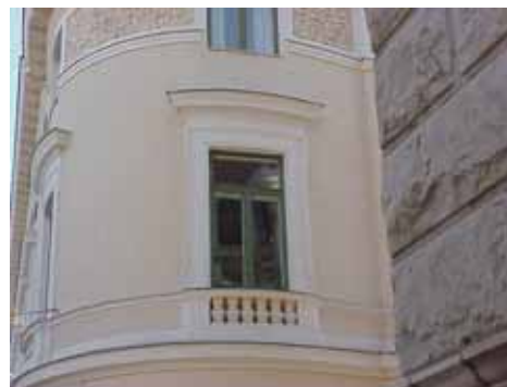
FRIGGA 7 från N FÖNSTER
