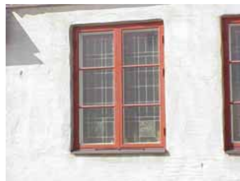
HEDVIG 18 från NO FÖNSTER
