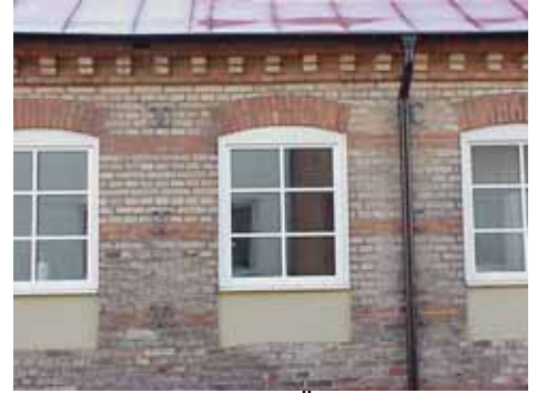
INGVAR 6 A från N FÖNSTER
