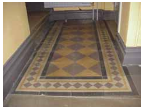
JOHAN 45 B TRAPPHUSGOLV
