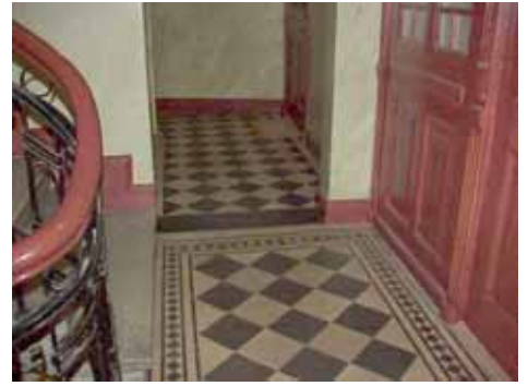
MAGNUS 33 A TRAPPHUS GOLV
