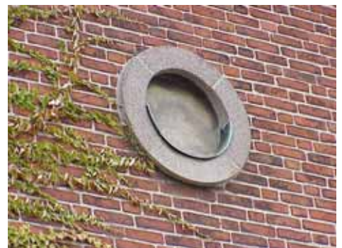
NIKLAS 3, hus C, fönsteröppning
