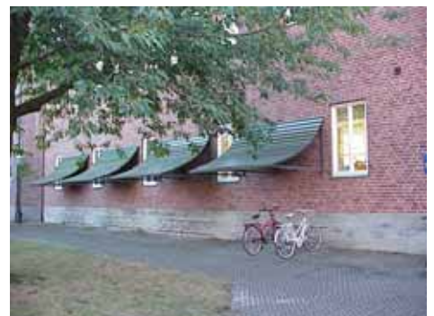
NIKLAS 3, hus C, från NV, cykelställ
