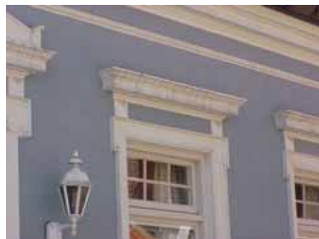
SIGRID 5 från N FÖNSTER
