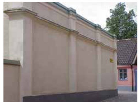
SORGENFRI 1 från SO, MUR
