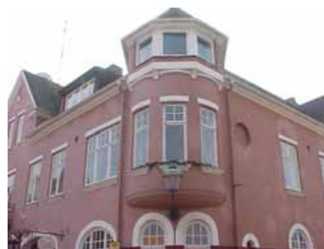
UBBE 8 från NO TORN
