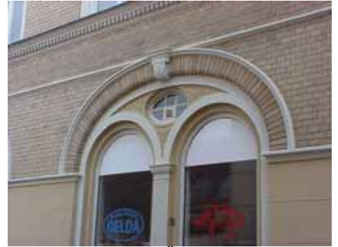
UBBE 6 A från S FÖNSTER
