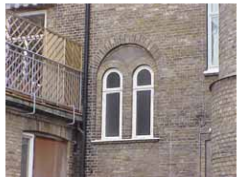
UBBE 6 A från NV FÖNSTER
