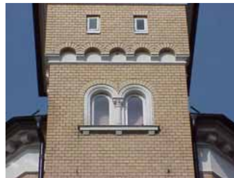
UBBE 6 A från SV TORN FÖNSTER
