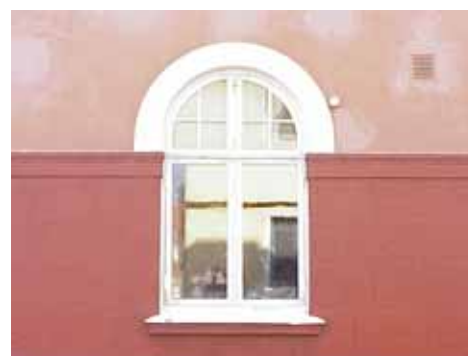
UBBE 8 från N FÖNSTER
