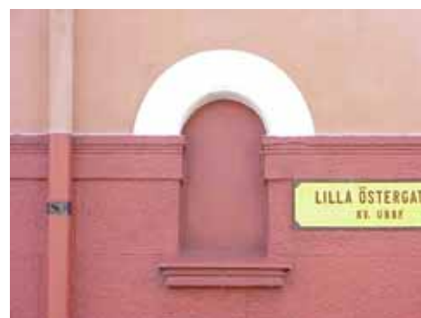
UBBE 8 från N F.D. FÖNSTER
