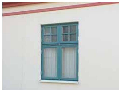
YNGVE S 2 A från N FÖNSTER
