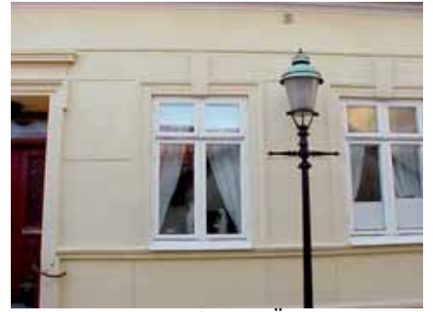
YNGVE S 11 A från O FÖNSTER
