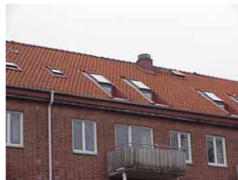
YSTAD 4 från SO, TAKFÖNSTER
