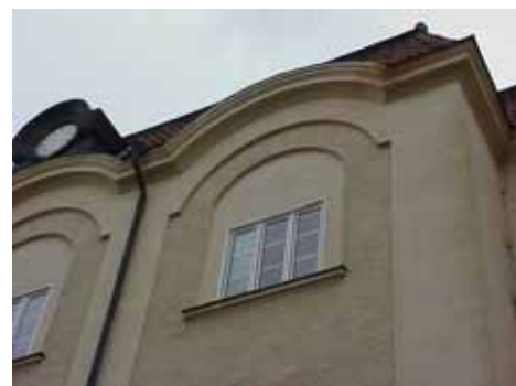
ZISKA 5 från NO, FÖNSTER
